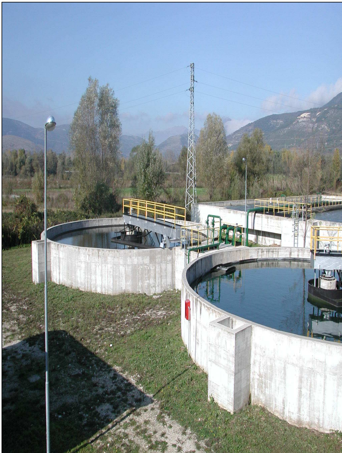
Vasche di sedimentazione -Impianto di Depurazione Consortile (Corfinio)
