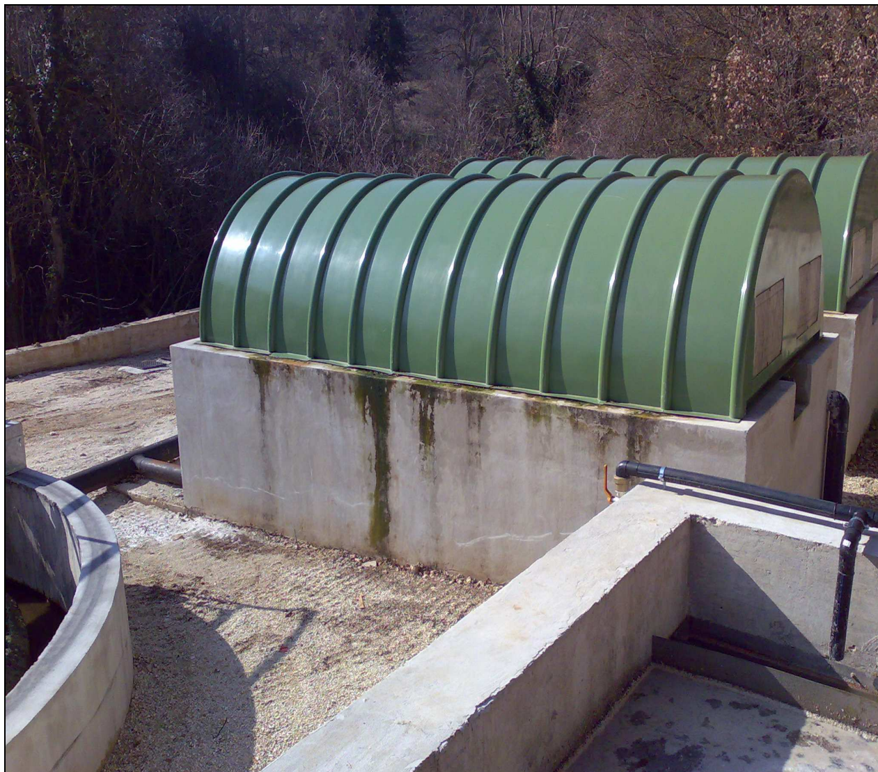
Biorulli -Impianto di Depurazione Goriano
